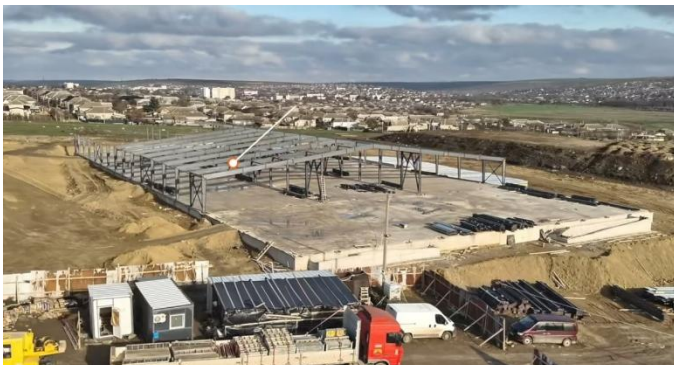
Рисунок 23. Производственные площади 5200 м.кв. на этапе строительства
