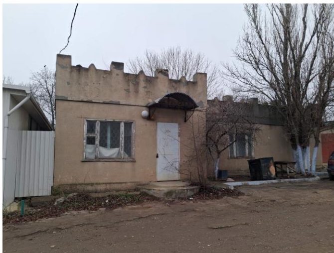
Рисунок 22. Зброшенне здание паспортного стола
