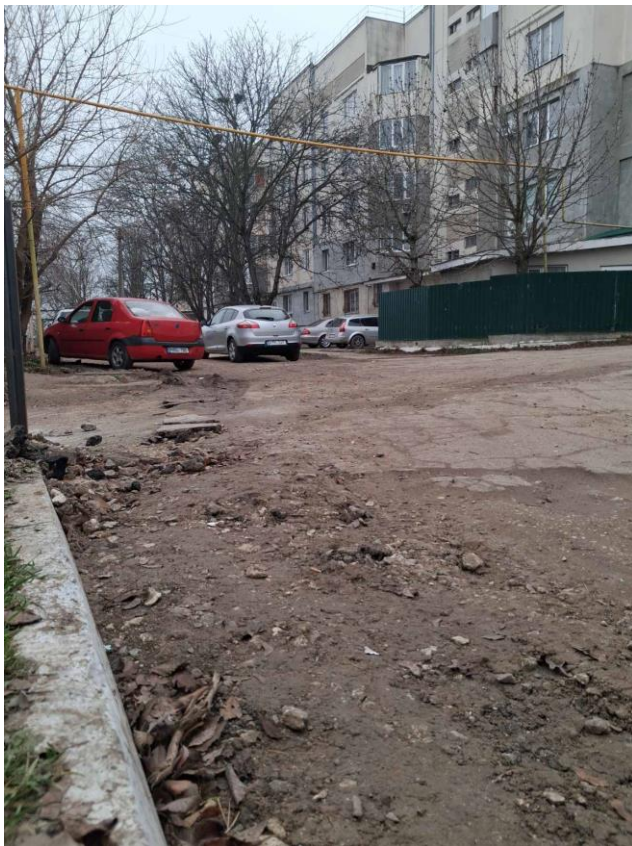
Рисунок 31. Двор многоэтажных домов в районе лицея им. Губогло
