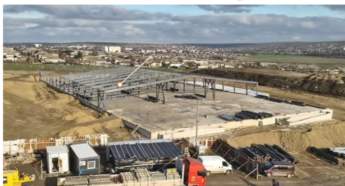
Рисунок 23. Производственные площади 5200 м.кв. на этапе строительства
